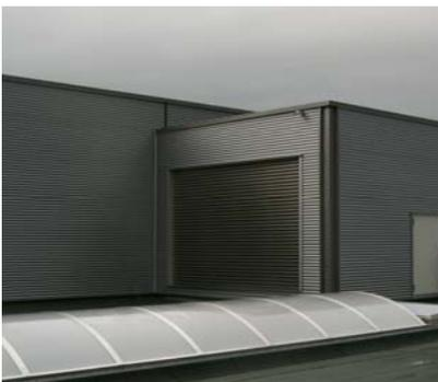
Bei dem neuen Werk in Marksuhl errichteten wir die Dachunterkonstruktion sowie die Fasadenskonstruktion. Diese besteht aus einer waagrecht verlegten wärmedämmten Kassettenwand auf welcher, auf einer zusätzlichen Unterkonstruktion, wiederum waagrecht die Außenschale aus Wellblechen und Trapezblechen befestigt wurde.
