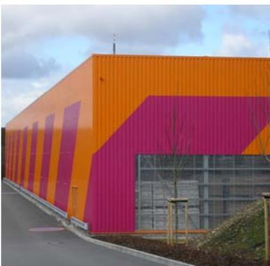
Unser Unternehmen führte die Fassadenkonstruktionen als einschalige Trapezblechwand, als Kassettenwand bzw. als ISO- Wand, sowie die Dachkonstruktionen der Haupt- und Vordächer als Tragschale für eine Folienabdichtung, als einschalige Trapezblechkonstruktion mit Antitropfbeschichtung oder als ISO-Dach aus.
